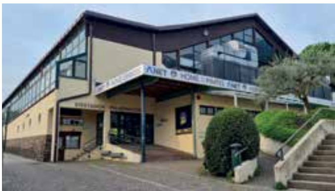
Ein Austausch der Eisanlage ist dringend notwendig.
